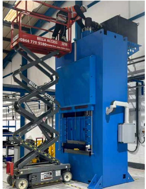
Installation of a special 300 ton press with 1000 mm stroke Installation einer speziellen 300 Tonnen Presse mit 1000 mm Hub Installation d'une presse spéciale de 300 tonnes avec une course de 1000 mm Instalación de una prensa especial de 300 toneladas y 1000 mm de carrera
